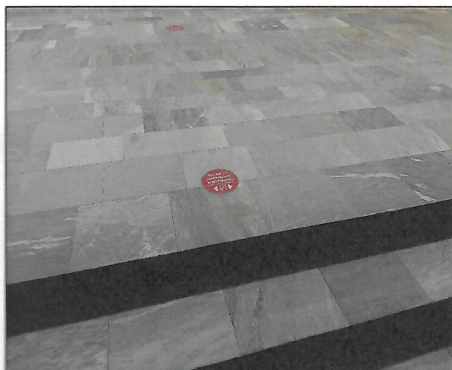
31.Площадка между лестницами
