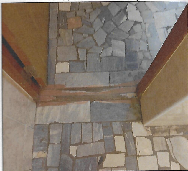
93. Порог входа в санузел
