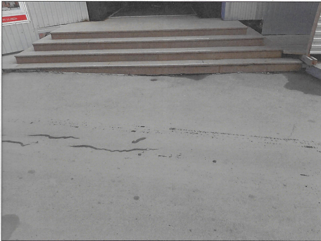
10.Площадка перед входом
