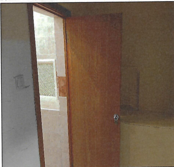
92. Проем входа в санузел
