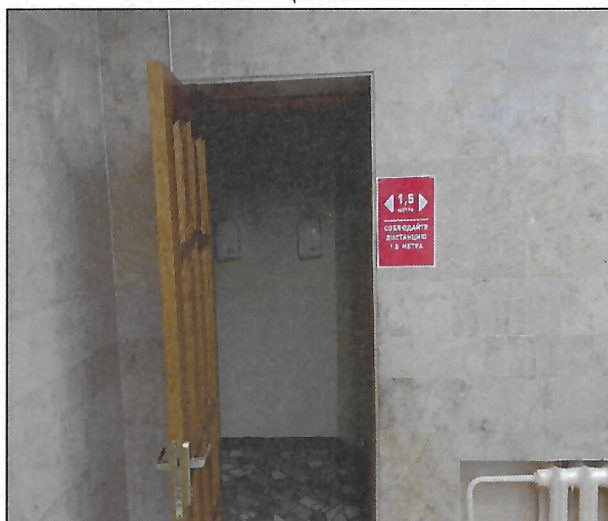
102.Вход в мужской санузел
